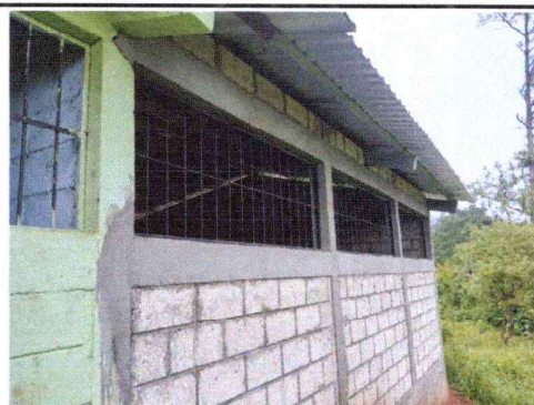
Foto 4: Se observa la parte posterior del aula remozada.
