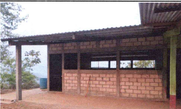
Foto 3: Se observa la estructura de metal empleado en la puerta y los balcones.
